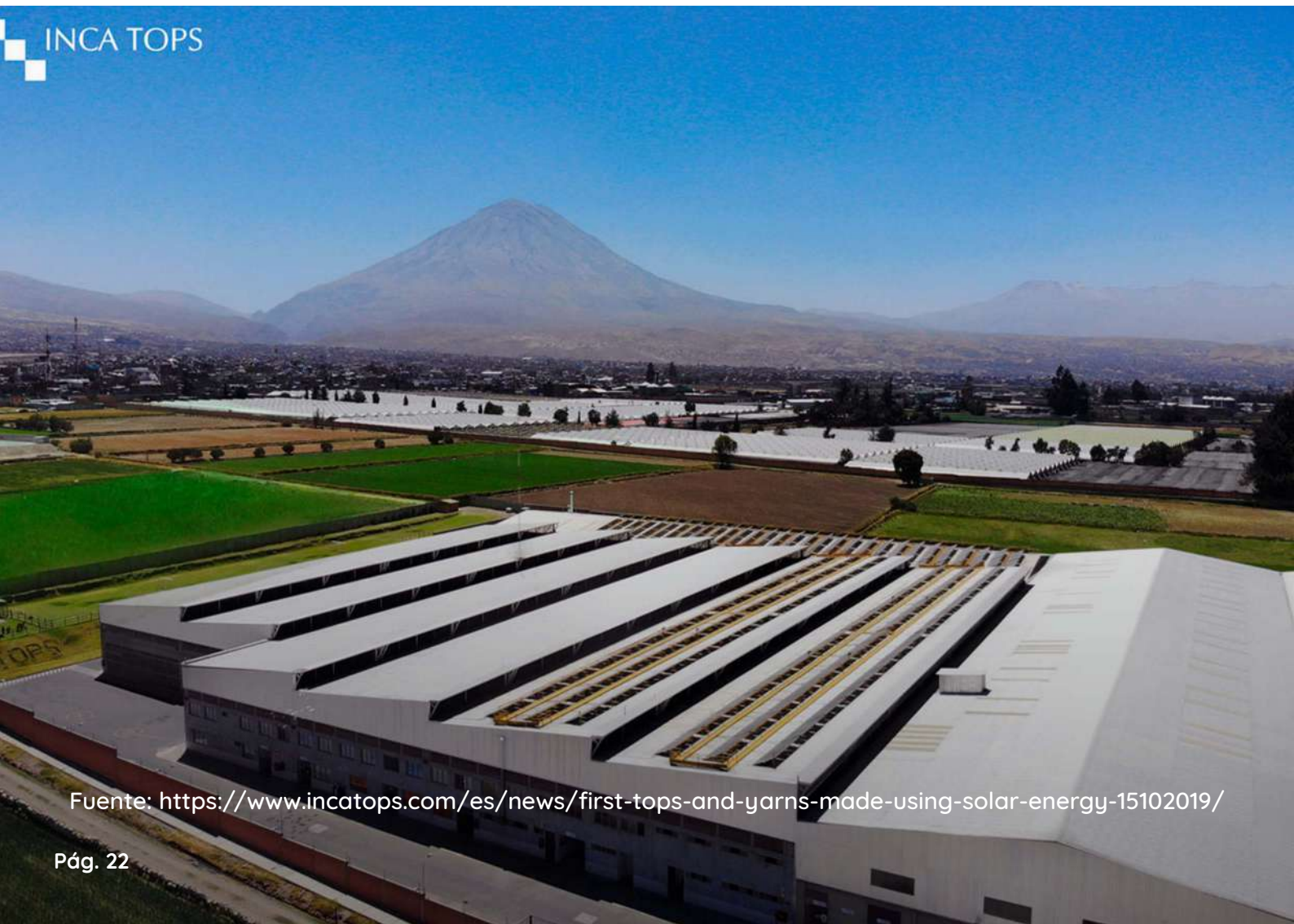
Figura 8. Instalaciones INCATOPS, Perú.
